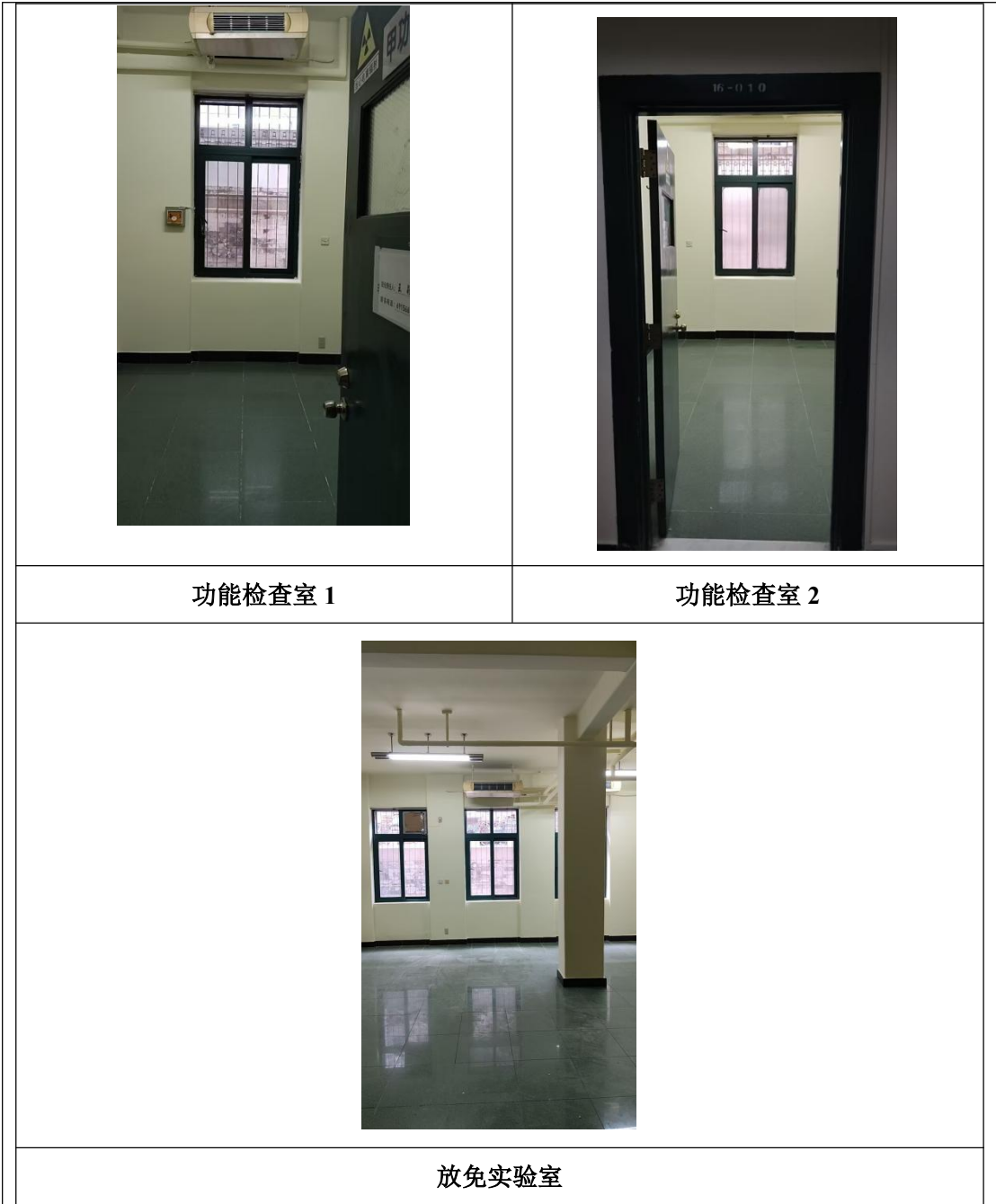
图 3-2 核医学科放免治疗区退役过程
