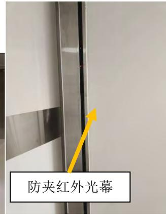
机房防护门的门机联锁装置和防夹人系统
