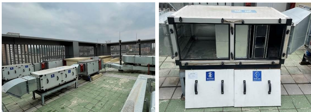
图 4-3 排风管道及过滤设备布置情况
